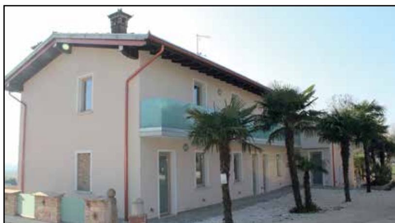
La palazzina ad uso B&B.
